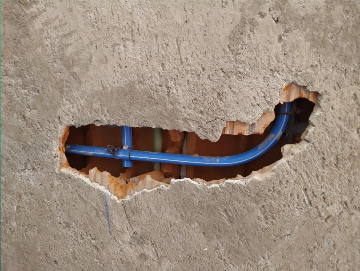
De igual manera queda dentro de los muros evitando ranurar y agregar conexiones, la curva natural de la manguera hace el trabajo
