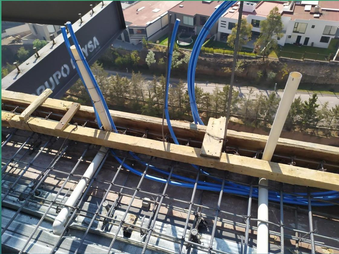
La instalación hidráulica se deja ahogada en el colado de losas, es flexible y resistente.
